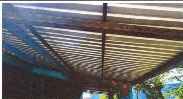
Foto 1: Módulo 1: Lijado y limpieza de corrosión en Estructura de techo.
