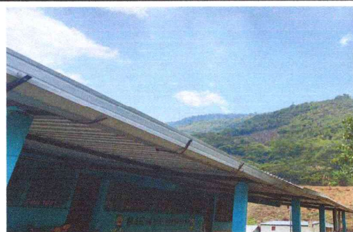
Foto 2: Módulo 1: Canales y bajadas de agua pluvial.
