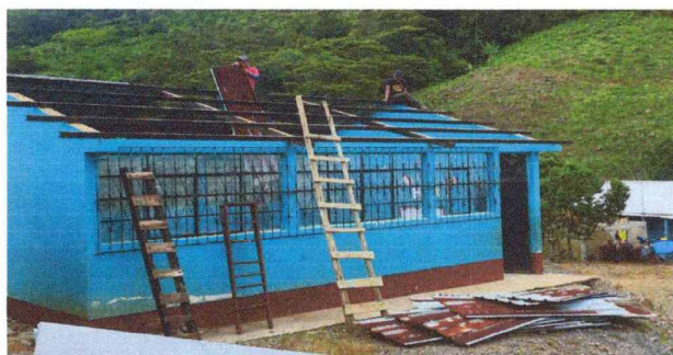
Foto 3: Aula 3: Desinstalación de Láminas con corrosión.
