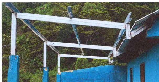
Foto 4: Cocina: Estructura de Techo sustituido.
